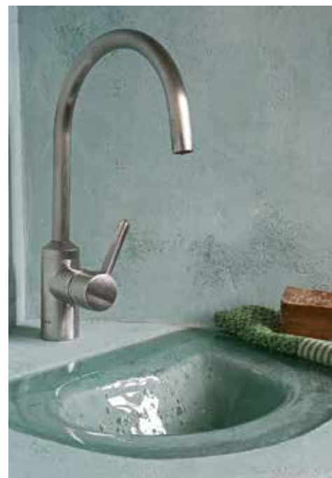
Kleine Lösung im Gäste-WC: Die Konsole für das eingelassene Schmelzglasbecken hat Mario Scheucher gemauert und farbig passend verputzt.
