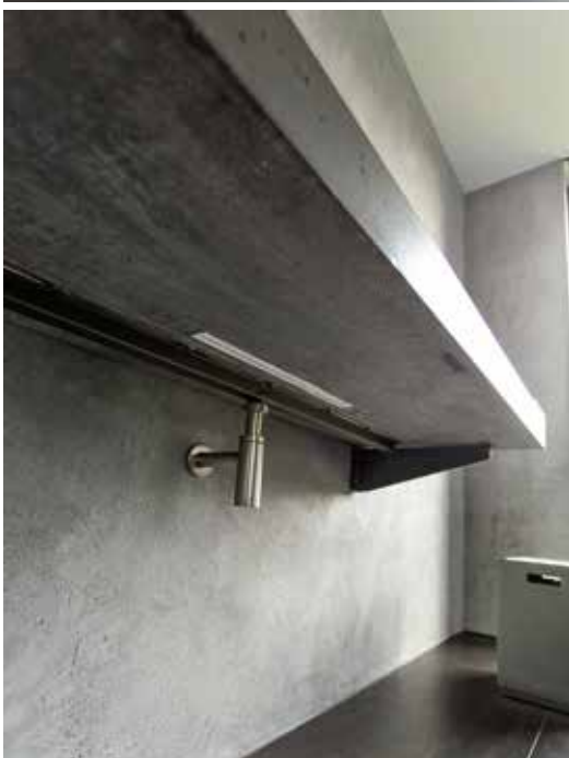
Daran haben auch zwei Personen gleichzeitig Platz: rampenartiger Waschtisch mit Abflusssrinne, wandhängend auf zwei Metallkonsolen angebracht.
